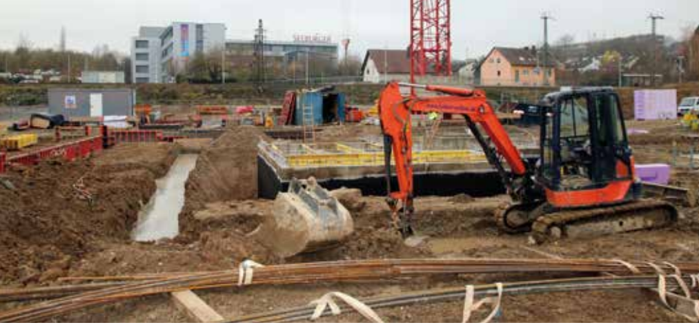
Nach erfolgtem Start gehen die Arbeiten zügig voran – Foto © DW
